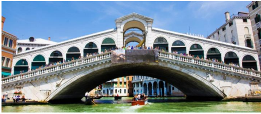
Figuur 7. Ponte di Ralto
